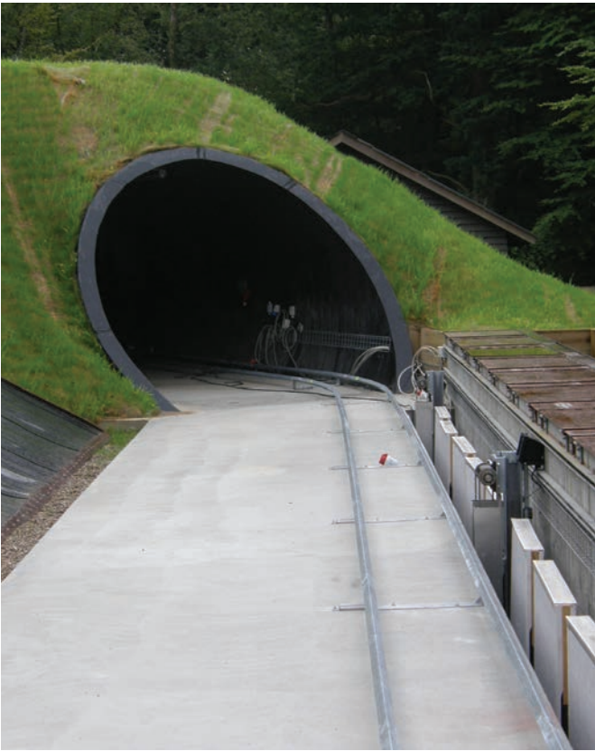
Antvorskov, Danmark: ID 3000 SN4 Weholite designet oplagrings- og fremføringsrør for skydeskiver på det militære øvelses-terræn i Slagelse. Skydeskiver bliver elektronisk styret og fremført på skinner, der er lagt på et mellemdæk i røret. Weholite-løsningen havde flere fordele. Ud over let håndtering og kort installationstid havde Weholite-rørene den sikkerhedsmæssige fordel, at der ved eventuelle fejlskud ikke vil være richterring af kuglen.
