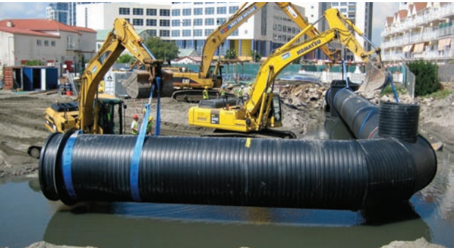
Gibraltar: En specialdesignet Weholite rørstruktur blev installeret i en regnvandsudløbsledning.
