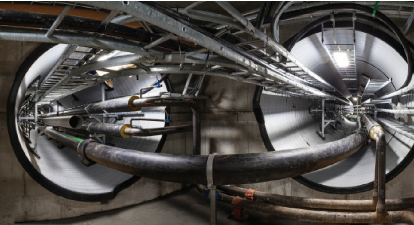
Linköping, Sverige: Som en del af en større opgave, fik Uponor Infra til opgave at udvikle, designe og installere en infratunnel, der indeholder rørføring til drikkevand, spildevand, el, telekommunikation, opvarmning og køling til et nyt boligområde. Den 1,8 km lange tunnel blev udført af Weholite-rør, ID 2200 mm.
