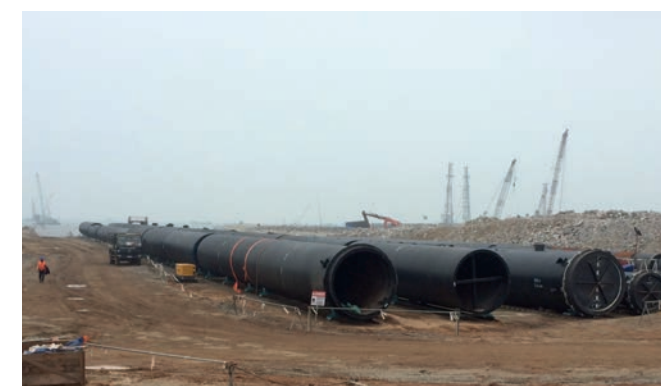
Nghi Son, Vietnam: Marineudløbsledning på olieraffinaderi med Weholite ID 2700 mm og 2025 mm. Den samlede ydelse omfattede ingeniørarbejde og design, svejsning og fyldning af profil samt tilsyn med installationen.
