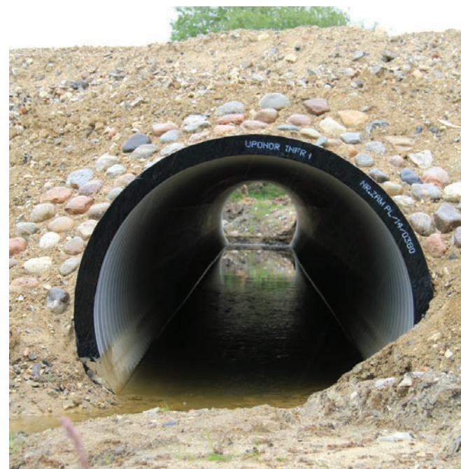
Danmark: I forbindelse med etableringen af den nye jernbane fra København til Ringsted, var det et krav fra myndighederne, at der blev taget hensyn til faunaen i de berørte områder. Derfor etablerede man 21 stk. ID1800/1600/1500/1400/1200 SN8 Weholite faunapassager, så dyrenes oprindelige habitater stadig var tilgængelige. Faunapassagerne i Weholite er godkendte af DSB med det anerkendte rådgivningsfirma Atkins som rådgiver.
