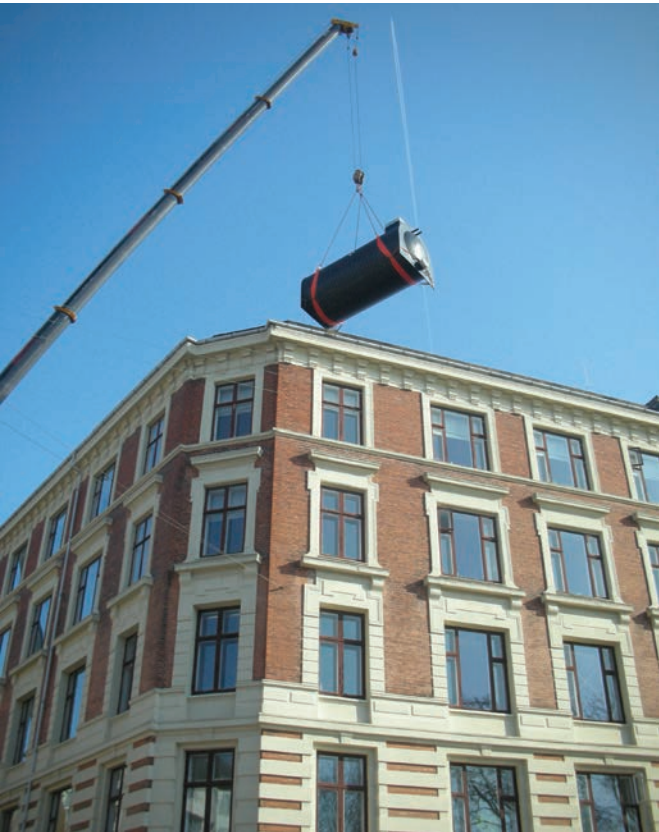
København, Danmark: Weholite-røret er den oplagte plastløsning til de københavnske baggårde, der har minimale adgangsforhold. Denne præfabrikerede ID2600 SN4 Weholite-tank med indbygget skraldeværn, kunne p.g.a. sin lette vægt nemt installeres med et løft hen over de 5-sals bygninger, der omkransede gården. Det tog kun 75 minutter fra ankomst, til tanken lå placeret i den forberedte rørgrav.
