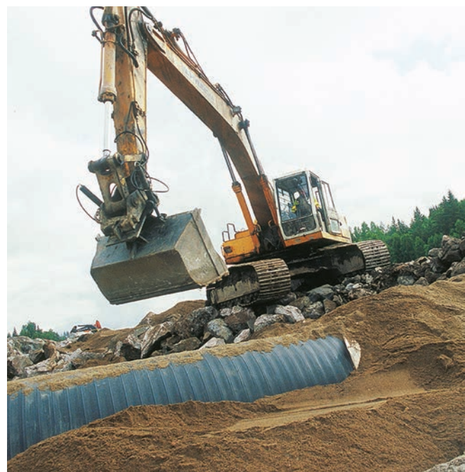
Hovedvej 4 Lahti – Heinola, Finland: Dette omfattende projekt havde til formål at fjerne trafikpropper mellem Lahti og Heinola og at forbedre trafikikkerheden. Weholite-rør ID 400-1800 mm blev leveret til projektet, hvor rørene blev installeret i åbne udgravninger som relining. En ekstern rapport om langtidsdeformation blev udarbejdet af VTT for Weholite underføringer ID 1600 mm SN4. Denne rapport er tilgængelig som VTT-S-11213-07, 19.12.2007.
