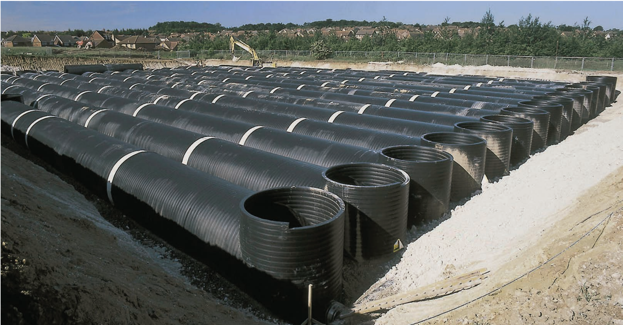
Bury St. Edmunds, Storbritanien: Et regnvandsanlæg fremstillet af Weholite-rør. Samlet længde 1200 m, ID 2800 mm. Total volumen er mere end 7000 m³.
