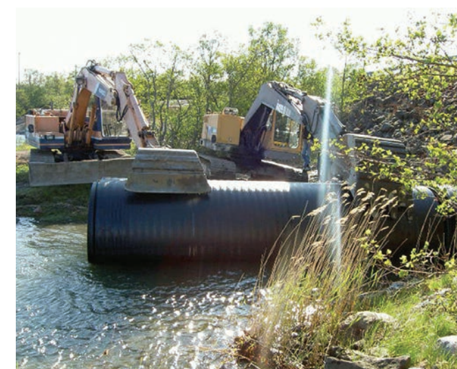
Åvabro, Ålandsøerne, Sverige: En gammel, korrugeret underføring i stål blev renoveret med sliplining af et Weholite-rør ID 1600 mm SN4. Samlet længde 30 m.
