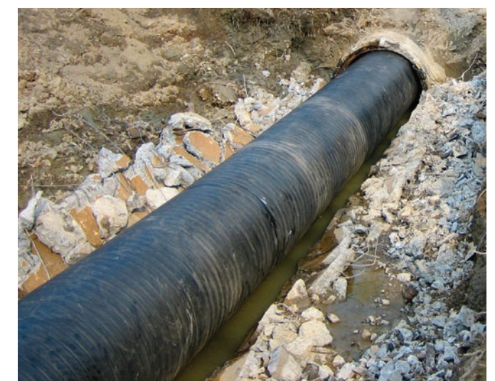
Hämeenlinna, Finland: En motorvejspassage blev renoveret med sliplining af et Weholite-rør ID 1000/1125 mm gennem et 1300 mm betonstrør. Samlingsmetode er ekstrudersvejsning. Samlet længde er 750 m.
