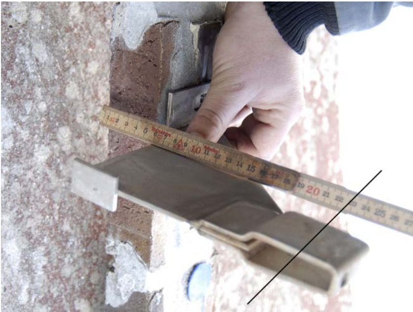
Fig. 2. Sådan findes indboringshøjden til limampulen. Ved denne konsol er indboringshøjden 23 cm. Her illustreret ved en streg.
