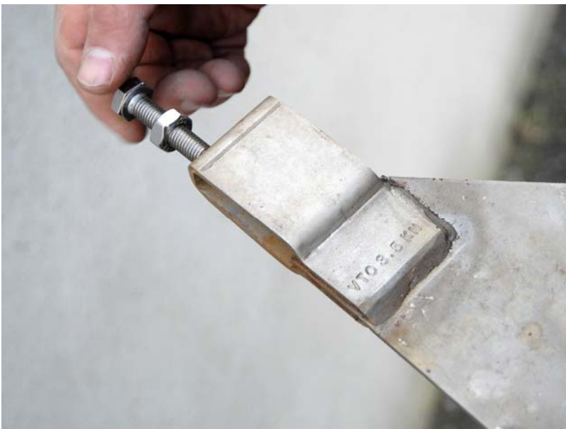
Fig. 9. Der monteres topbolt for finjustering af højde.
