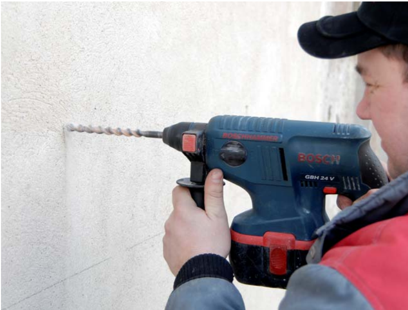
Fig. 4. Der bores med et 14 mm bor minimum 90 mm dybt.
