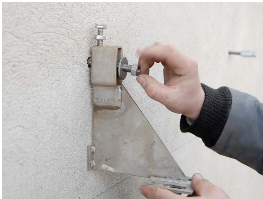
Fig. 10. Konsol monteres på indlimet gevindstykke.
