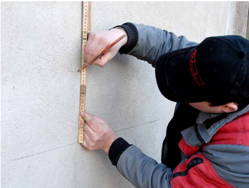
Fig. 3. Der måles fra vinduesfalsens overkant og de 23 cm, som vi fandt på fig. 2. Længdeplacering af konsollerne vil kunne findes på vedlagte tegningsmateriale fra Vils Tegloverliggere.
