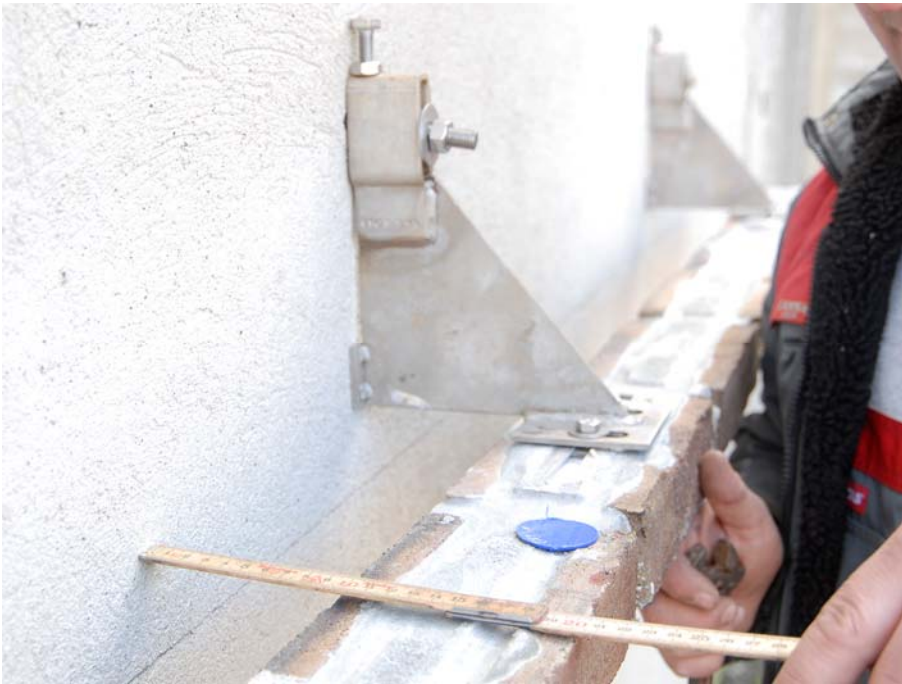
Fig. 17. Justering af dybde til bagmur.
