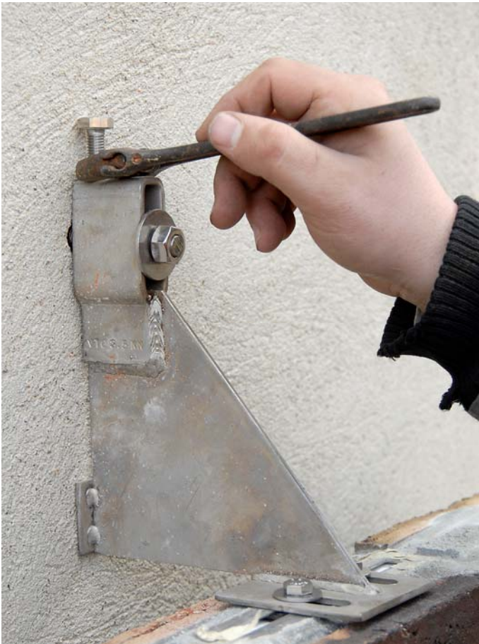
Fig. 19. Topbolten justeres, så overliggeren flugter med skiftegangen.
