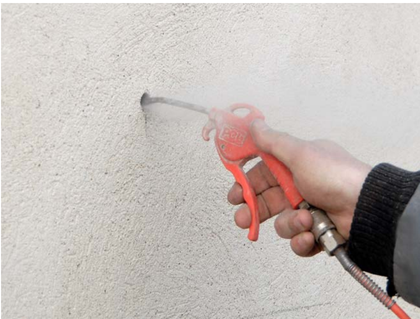
Fig. 5. Hullet blæses rent for støv.
