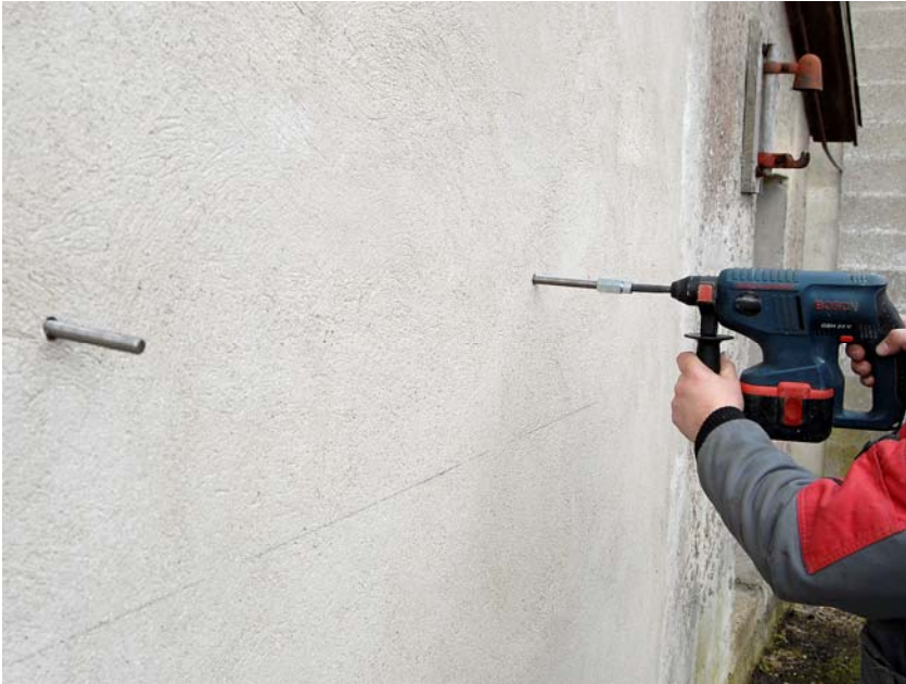
Fig. 8. Genvindstangens skrånede spids stikkes ind i limampulen og der bores med slagboremaskinen ind i limampulen. Hærdetiden på limampulen vil variere afhængig af temperatur og kan aflæses på medsendte æske.
