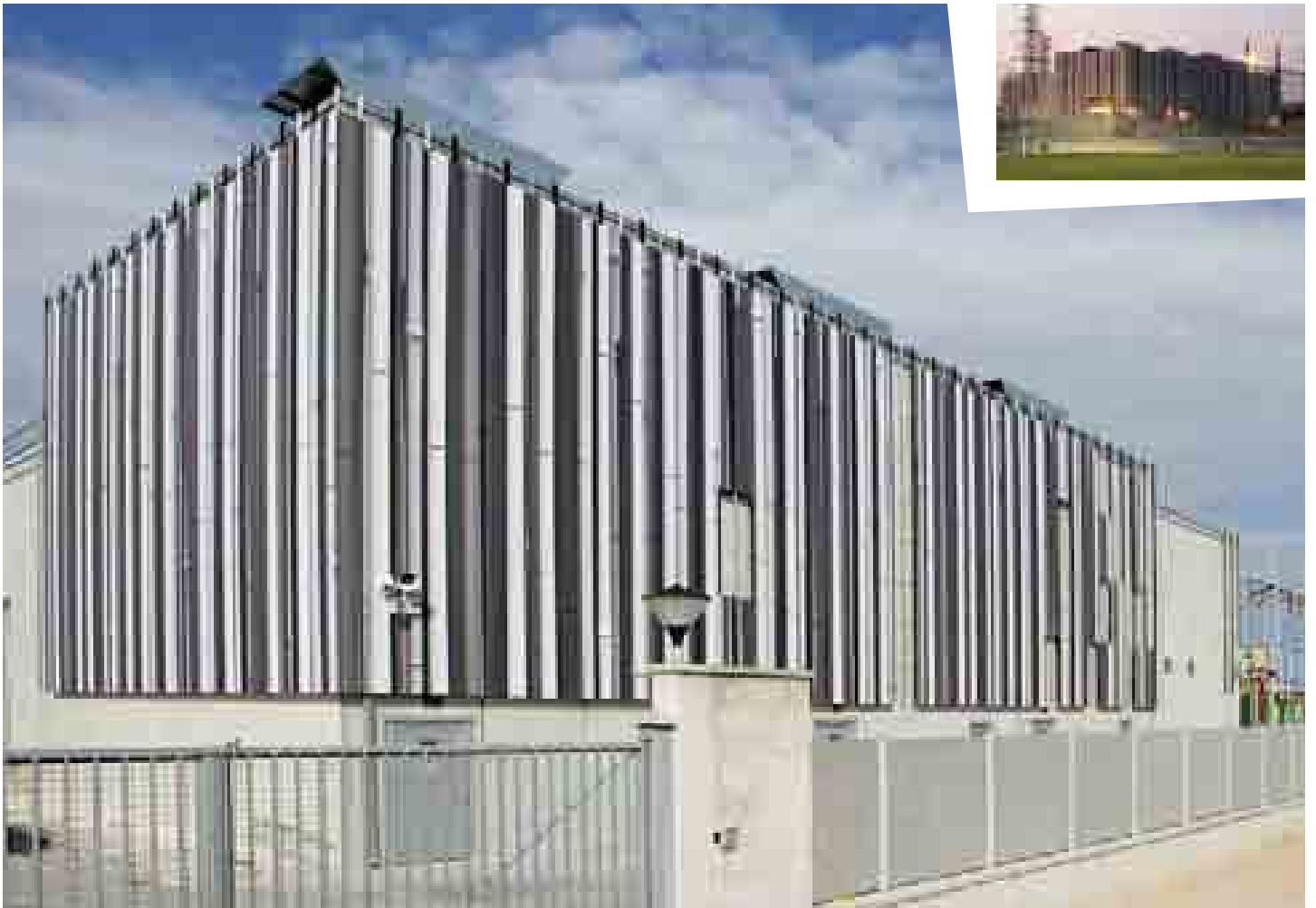
Transformerstation Beniferri-Valencia. Tomás Llavador Arquitectos+Ingenieros.
