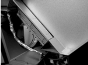
På billedet ses slangen med varmekabel fra det eftermonterede afløb
