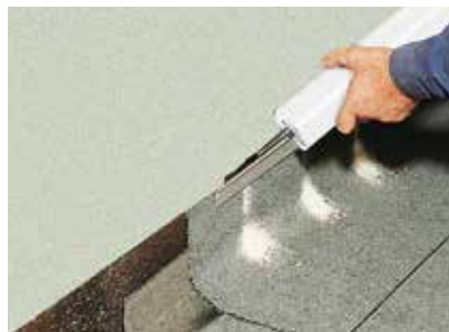
Op mod mur af beton
