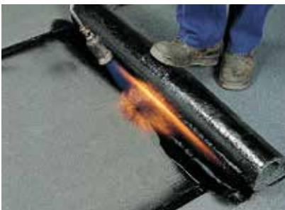
Et "bad" af smeltet bitumen foran rullen
