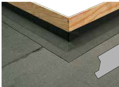
Udvendigt hjørne: Anden understrimmel vist som principskitse
