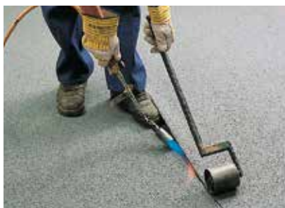
Overlægget svejses til sidst
