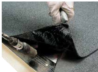
Hold hjørnet oppe med kniven
