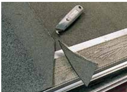
Snit hjørnet for pæn afslutning
