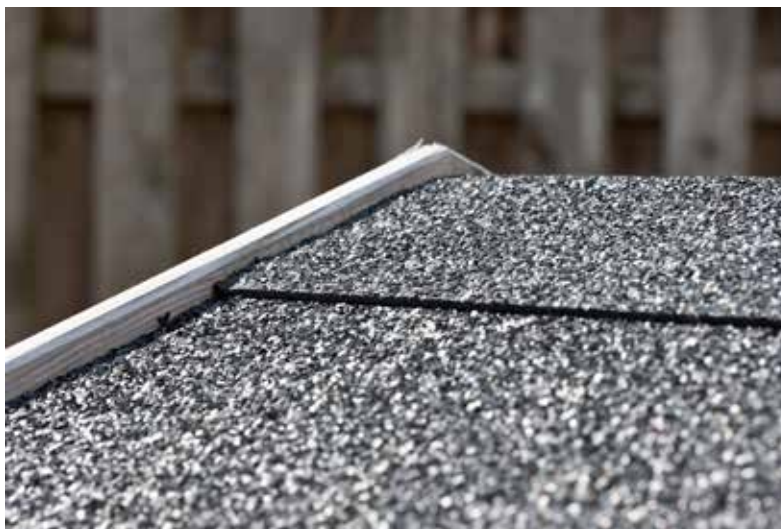
På små tage med hældning kan der laves en god tagdækning med PF/GF 5000 SBS Selvbyggerpap
