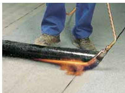
Ret brændehovedet mod kanten
