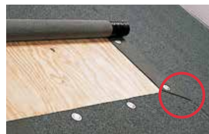
Hjørnet snittes, inden endeoverlægget lukkes
