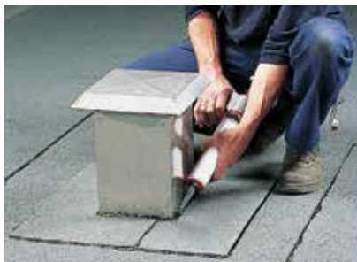
Til sidst fuges langs kanten
