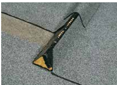
Trapezliste, bitumenoated mineraluld til listedækning
