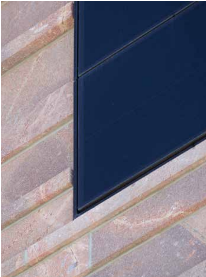
Detaljefoto af overgangen mellem den usynlige fastgørelse af solcellepanelerne og naturstensfacaden.
