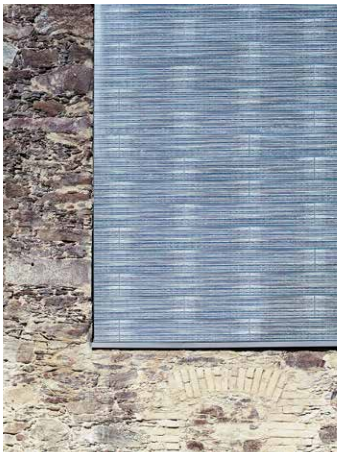
Serigrafi af motiv med stablede glasplader og trykte glaselementer på bagsiden.
