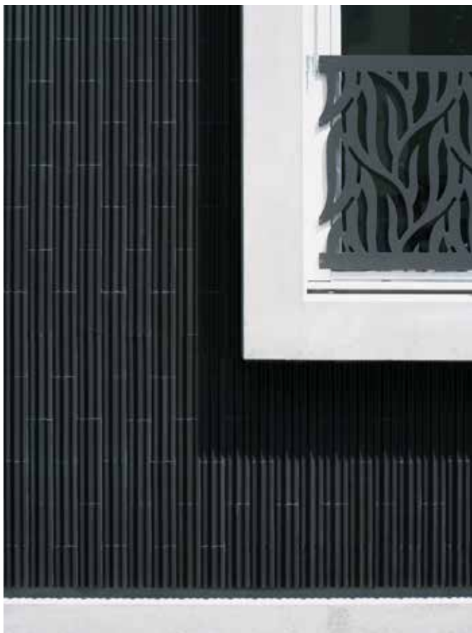
Materialeovergang fra sokkel og vindue til keramikfacade
