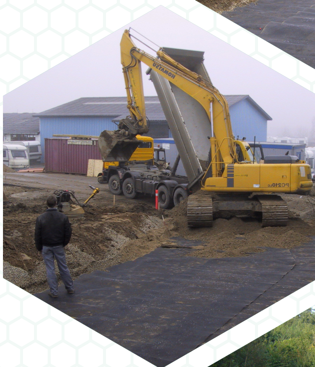
Vejarmeringsprojekt samt parkeringsplads med anvendelse af EXPO-NET armeringsnet
