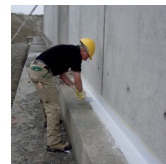
Vandtætning af kældere
