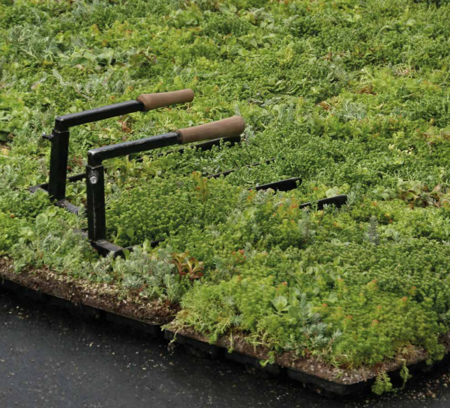
Nature Impact® Roof – Udlægning
