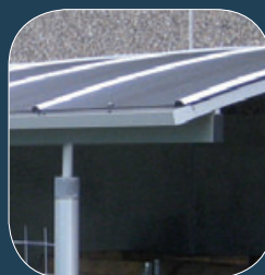
Tag / spær detalje Tagspær i valsede alu-profiler og diskret integreret tagrende, begge dele i naturelokseret alu-profil.
