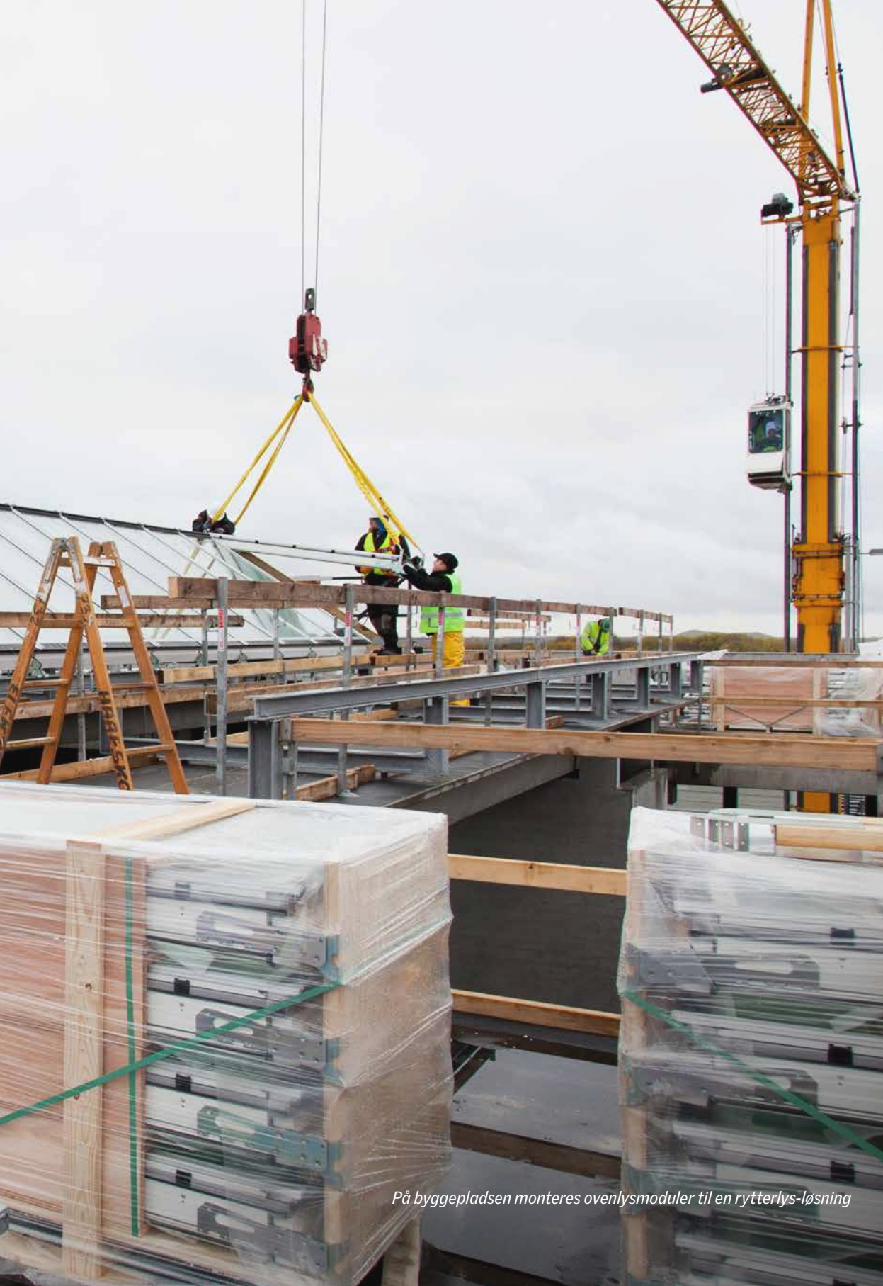
Montering af selv bærende rytterlys med ovenlysmoduler
