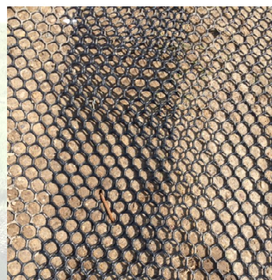
Nettet, der leveres i ruller á 2 m bredde, rulles ud med et overlap på ca. 15 cm.
