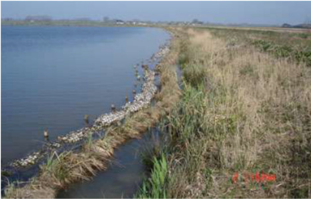
Beskyttelse af ArmaFlor Sivørsmåtter og rørgræsvalser mod bølger fra vind og skibsfart med BesTec Stenvalser, så etableringen lykkedes.
