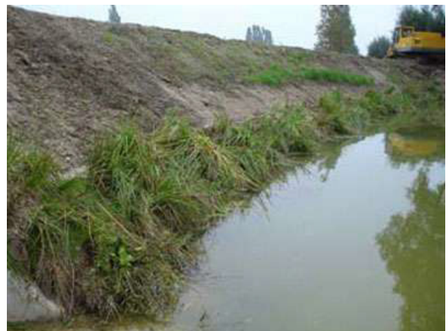
Armaflor Sivørsmätter direkte efter installering. Den på grund af forsendelsen liggende biomasse rejser sig ved egen hjælp efter ca. 2-3 dage.
