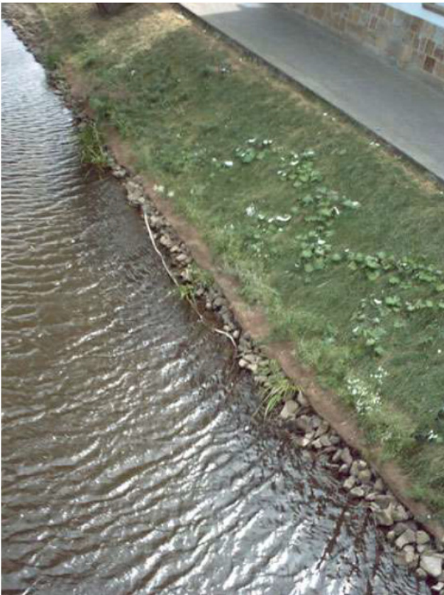
Eksempel på forkert installationssted, da der er ingen vand til ArmaFlor mätterne
