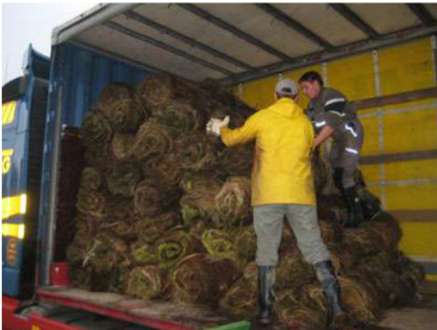
ArmaFlor Sivrørsmåtterne bliver lastet sammenrullet og stablet på lastbil
