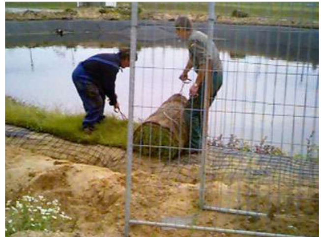
...installation på bassinfolie
