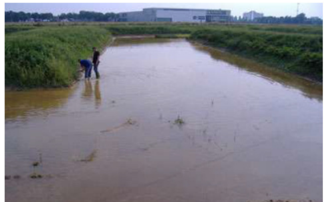
Installation af ArmaFlor Sivrørsmåtter i Frankrig
