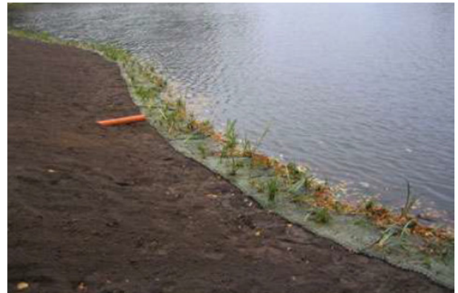
...f.eks. i kombination med BesTec Stenkammermåtter lagt over jorden.
