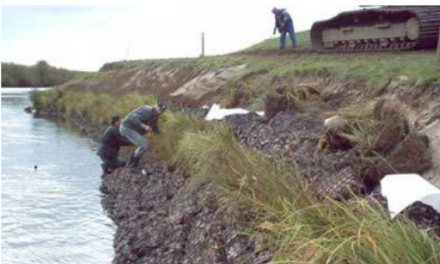
Installation af Composit Dækværksbegrønningsmåtter af BesTec Kammerdækværk
