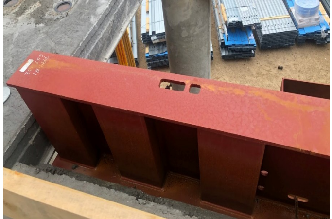
Figur 2: GSY BEAM™ leveres med løftehuller i overflangen
