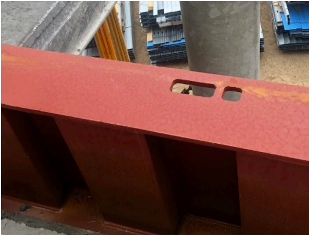
Figur 2: GSY BEAM leveres med løftehuller i overflangen
