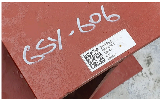
Figur 1: Hver bjælke bliver leveret med label med individuelt ID-nummer, hvor vægten af bjælken også fremgår.
