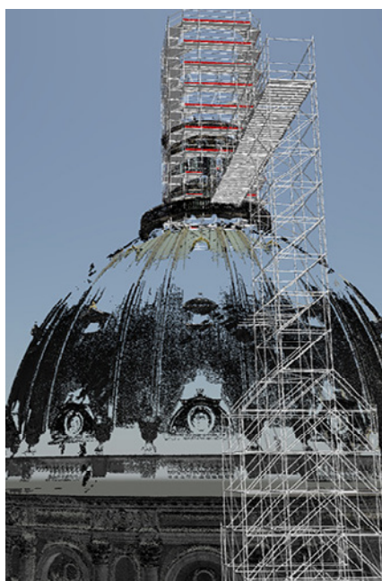
Stilladset designet ud fra Point Cloud-scanningen.
