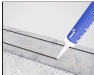
Der udlægges 2 striber butylfuge inden folien udrulles
