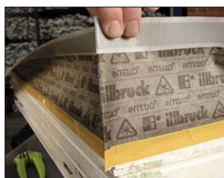
Folien monteres til karmen inden vinduet monteres. Alle hjørner udføres med en fold på 1-2 cm, for at folien kan nå ud til hjørnet af lysningen.
