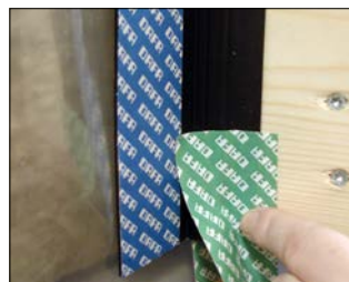
DAFA spærfodskrave forsegles på den åbne side med DAFA grøn dampspærretape
