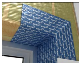
DAFA udvendigt hjørne, monteret i vindueslysning
